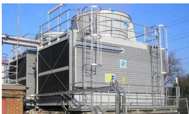
L'acqua di raffreddamento per il ciclo frigorifero dei chiller di stabilimento viene attualmente raffreddata centralmente a mezzo di n. 5 torri evaporative con ventilatori di tipo centrifugo, con n. 2 vasche in cemento di raccolta e distribuzione.
